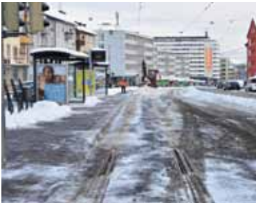
Weiter oben am Stern sind die Gleise schon freigeräumt. Bis zur ersten Linienfahrt wird es aber noch fast vier Tage dauern.
