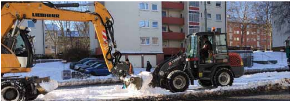
Schneeräumung an der Ihringshäuser Straße (Foto BS)
