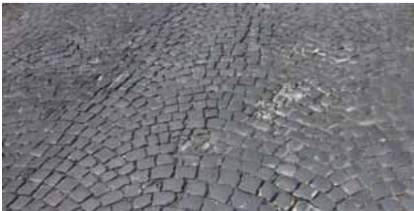
Spurrillen, lose, zum Teil zermahlene Pflastersteine, (Fotos: WS)
