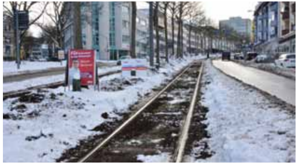
Freitag 12.02. Das Rasengleis in der Rudolf-Schwander-Straße ist mittlerweile auch wieder frei, der Rasen aber stark beschädigt.
